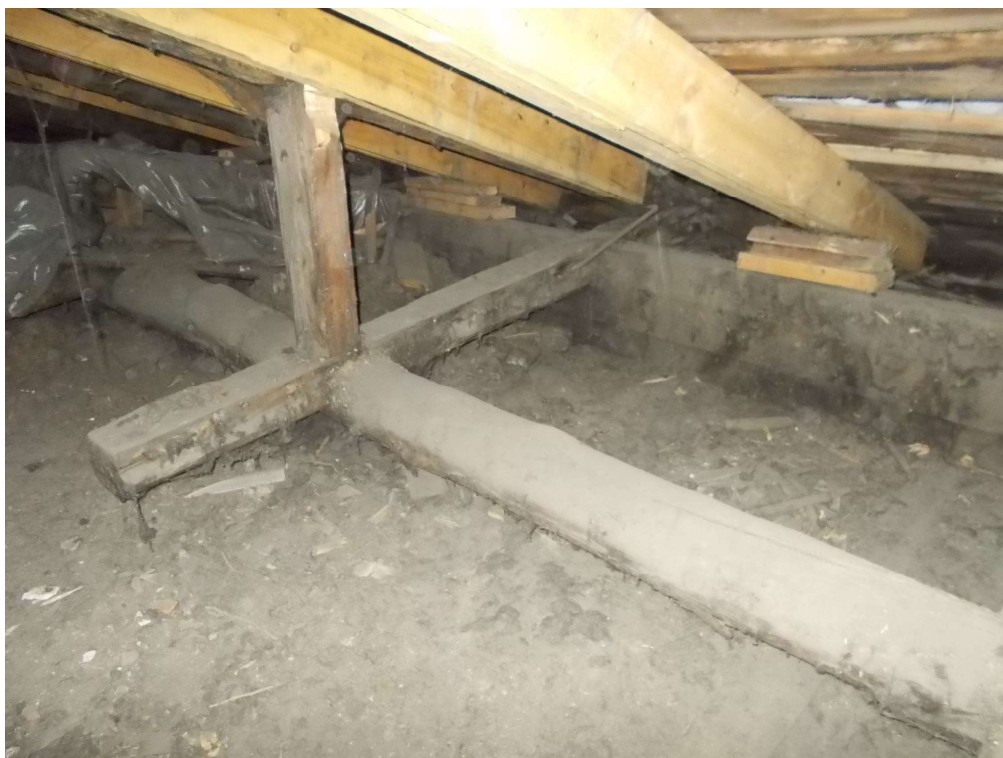
Рисунок 2.5.6 – Типовой опорный узел стропильных ног
