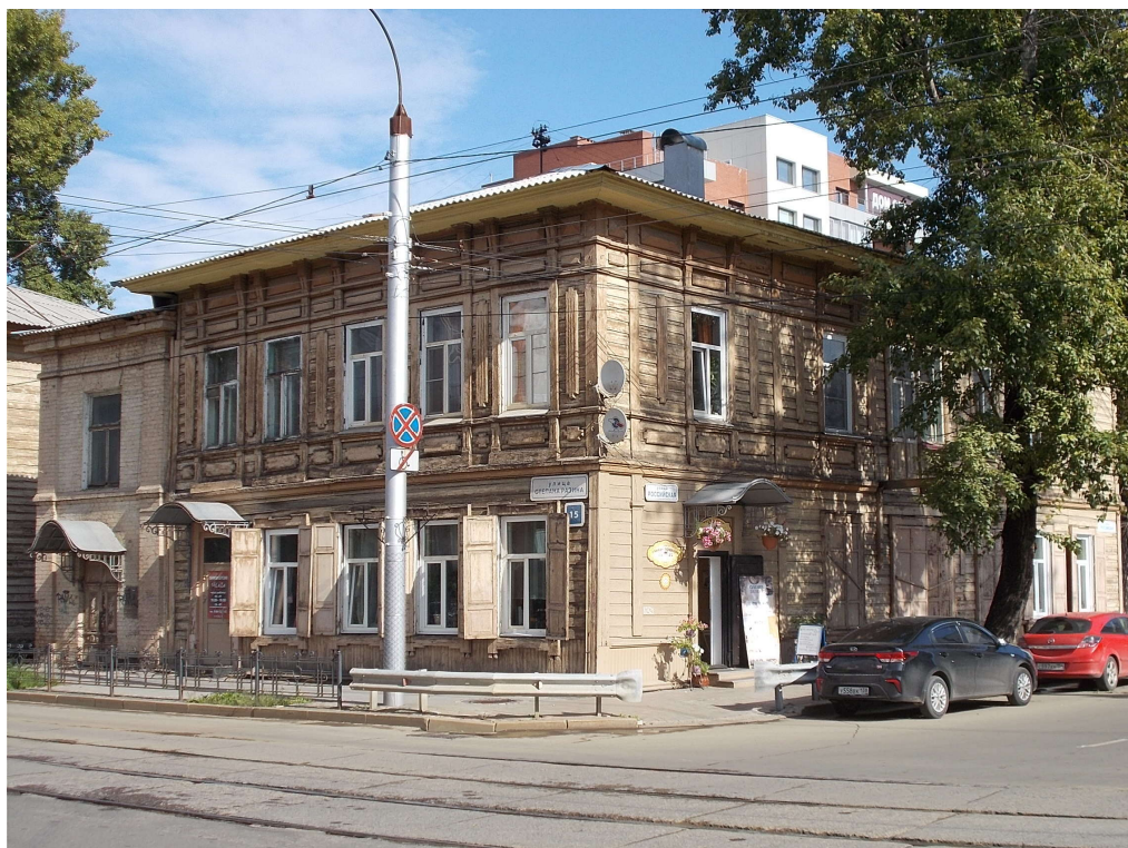
Рисунок 2.5.2 – Общий вид фасадов по осям А и 7
