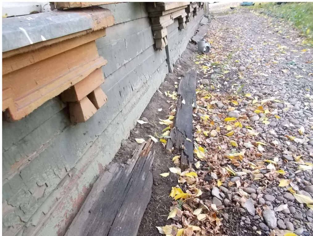
Рисунок 2.5.12 – Отсутствует отмостка
