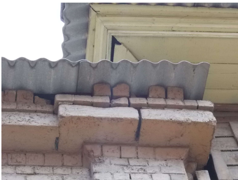
Рисунок 2.5.26 – Утрата отдельных кирпичей выступающих элементов фасадов
