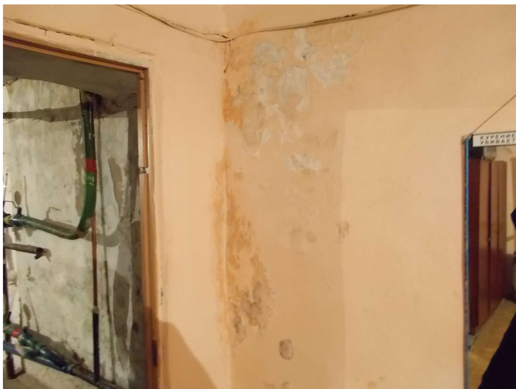
Рисунок 2.5.13 – Протечки по стене "И"
