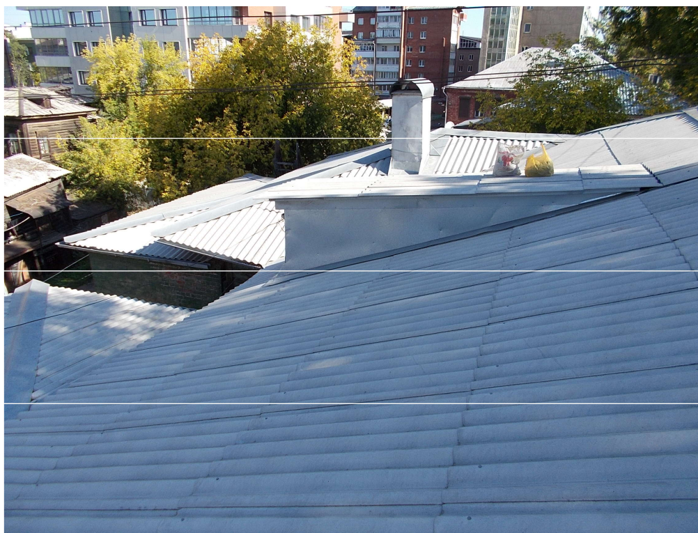
Рисунок 2.5.8 – Общий вид крыши (вид от оси А/1-5)
