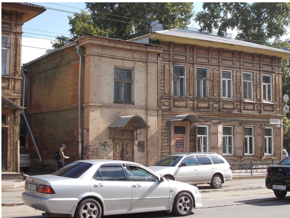
Рисунок 2.5.1 – Общий вид фасадов по осям А и 2
