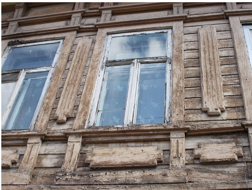
Рисунок 2.5.27 – Гнилостная деградация обшивки и элементов декора фасадов
