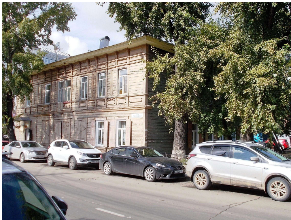
Рисунок 2.5.3 – Общий вид фасадов здания по осям И и 7
