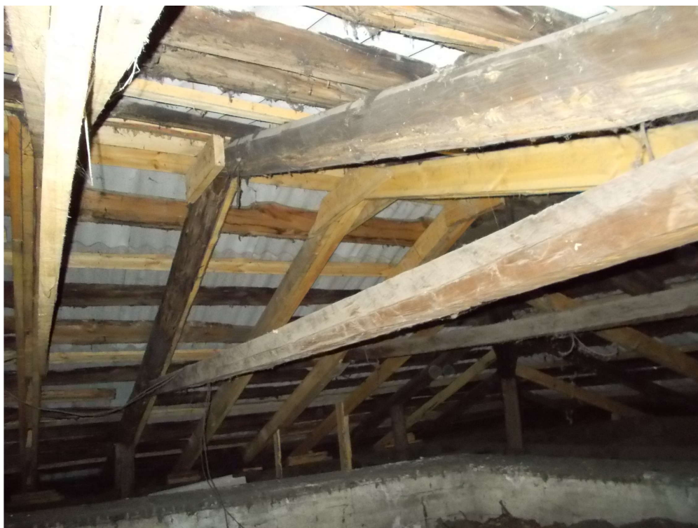
Рисунок 2.5.5 – Фрагмент стропильной системы в осях А-Д/4-7
