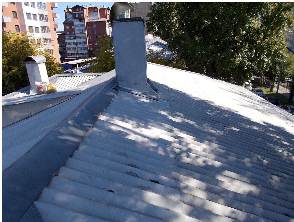
Рисунок 2.5.9 – Общий вид крыши (вид от оси А/5-7)
