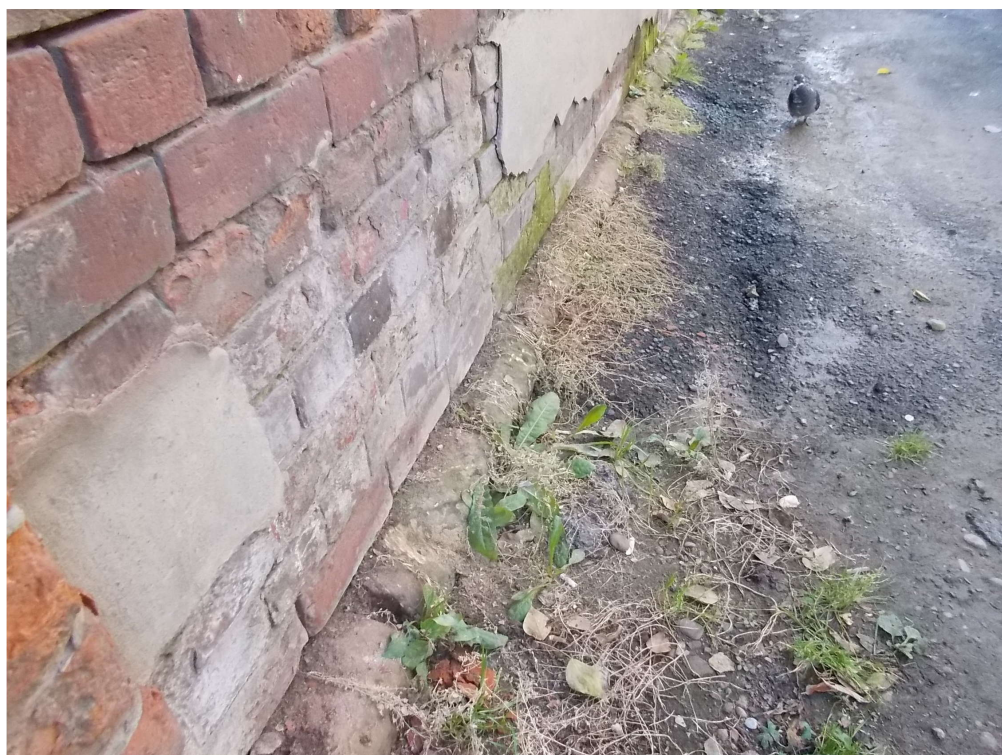
Рисунок 2.5.24 – Морозная деструкция кладки цоколя в осях 2/А-Д
