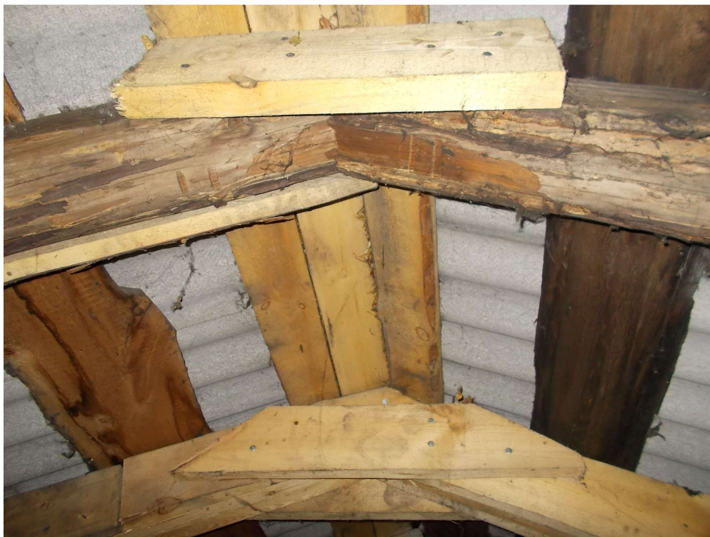
Рисунок 2.5.7 – Типовой коньковый узел стропильных ног
